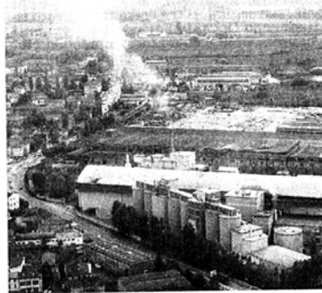
Lo stabilimento Fibronit di Broni
